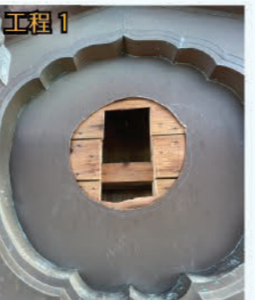
鬼飾りの中央「鏡板」に穴をあけて中を確認し、ボルトを増し締めする
