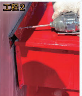
鬼飾りと棟のあいだに空いたスキマ。コーキングを打ち、ビスで固定する
