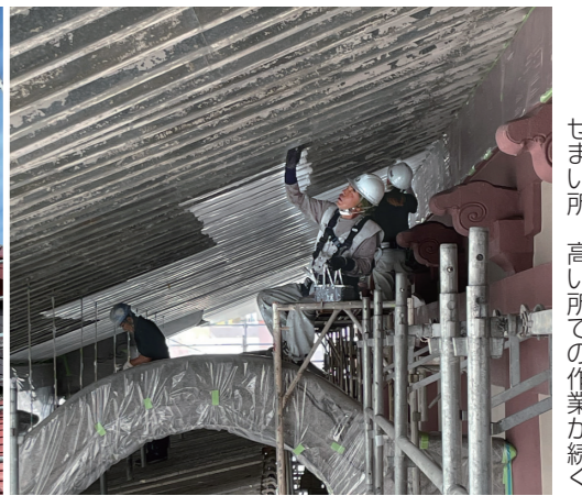
せまい所、高い所での作業が続く
