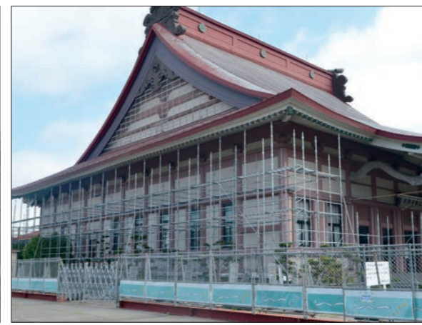
仮設足場に囲まれた本堂
