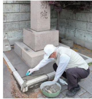
作業中の西田さん。傷んだ部分をしていねいに修理してください
