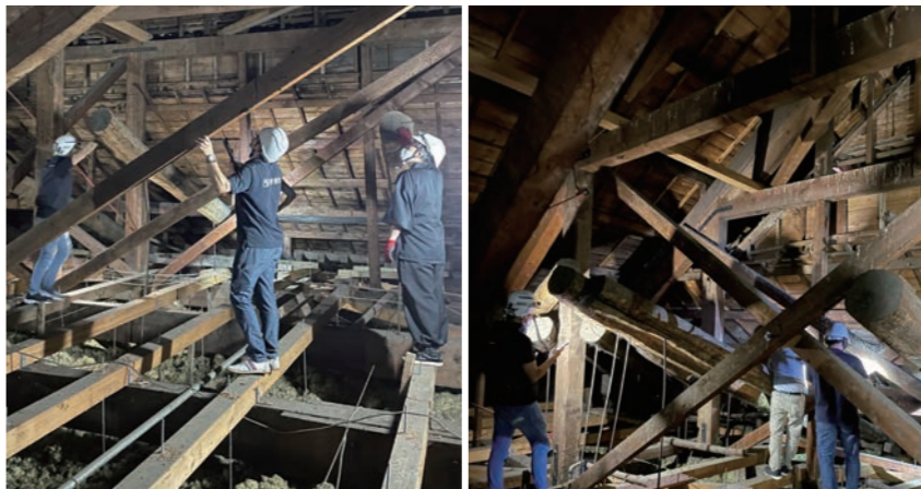
本堂屋根は高さ約25メートル。屋根を支えるのが、太い梁や丸太を組み合わせた小屋組。その傷みなどを詳しく調査した
